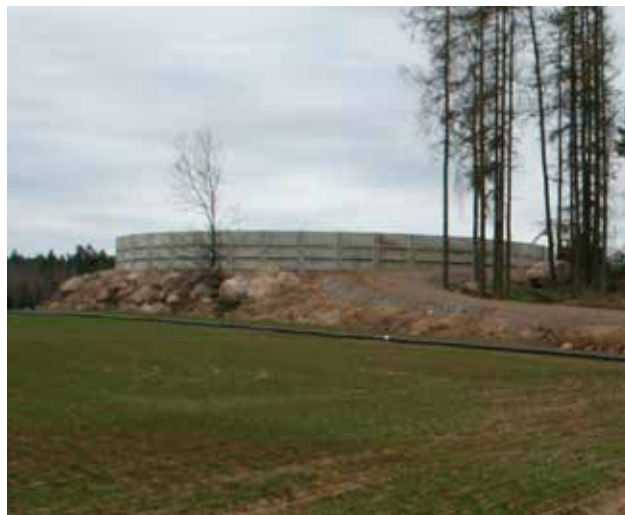
Kuva 2.5.3. Etälietelantasäiliö Augustenhillin tilan peltojen vieressä. Kuva: Claes Olai
