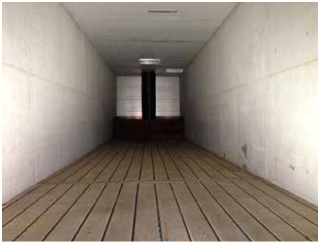
Kuva 2.4.3. Samagron kompostointitunneli. Kuva: Samagro NV
